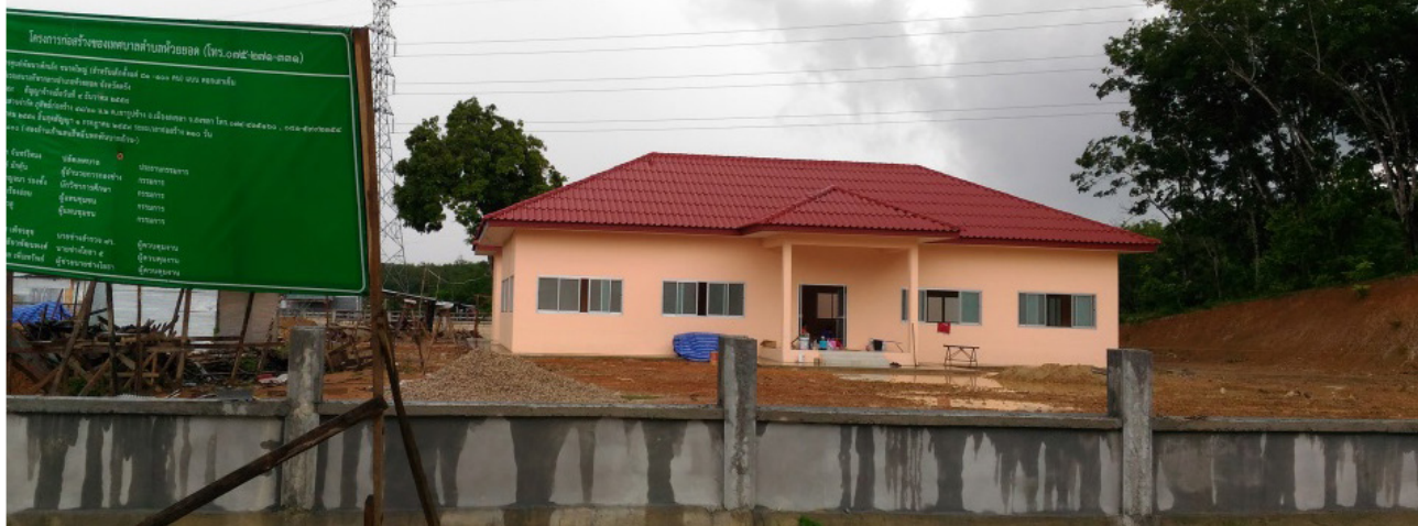
งานก่อสร้างอาคารศูนย์พัฒนาเด็กเล็ก อ.ห้วยยอด จ.ตรัง
