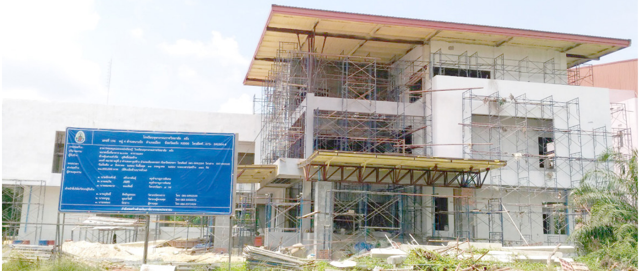
งานก่อสร้างอาคารหอสมุดโรงเรียนจุฬาภรณ์ อ.เมือง จ.ตรัง
